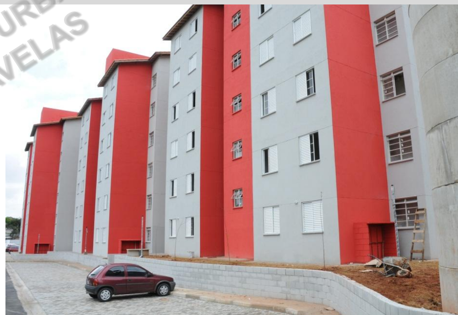
UNIDADES HABITACIONAIS CONSTRUÍDAS NA PRÓPRIA ÁREA PARA RELOCAÇÃO INTERNA
