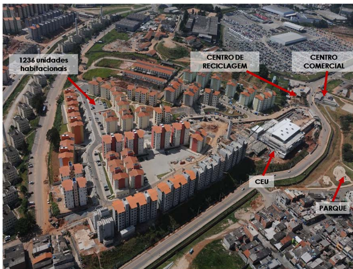
Figura 3 – Vista Aérea do Conjunto Três Marias (ainda em obras, hoje está concluído)
